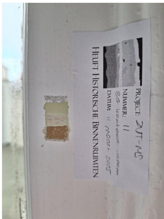
ZVT-MS-11. BG, venster in het voormalige kantoortje op de begane grond. De oudste kleur is dezelfde donker okergeel als elders. Maar de kamer heeft wel andere kleuren gehad in alle opvolgende kleurfasen.
