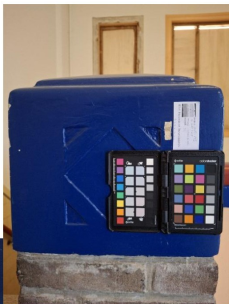
Stratigrafie ZVT-MS-31 laat diverse lichte kleuren zien op de hoekblokken van de trap. Het blok is vermoedelijk van graniet en was mogelijk oorspronkelijk niet beschilderd.
