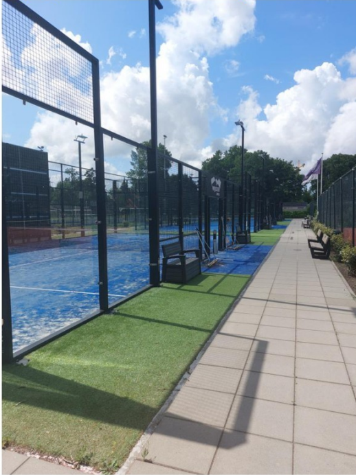
Bijlage: Foto's situatie geluidmuur LTC DEM, Spaarnestraat 1b, Beverwijk
