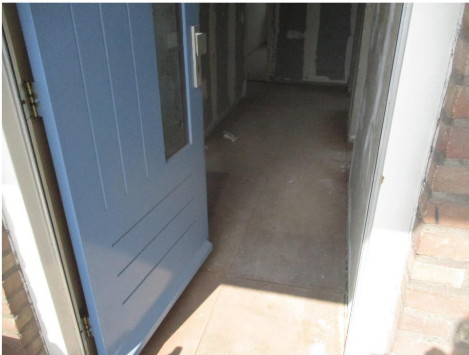
Foto 1: Zicht op de hal van de woning.
