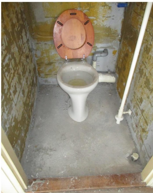
Foto 2: Zicht op het toilet.
