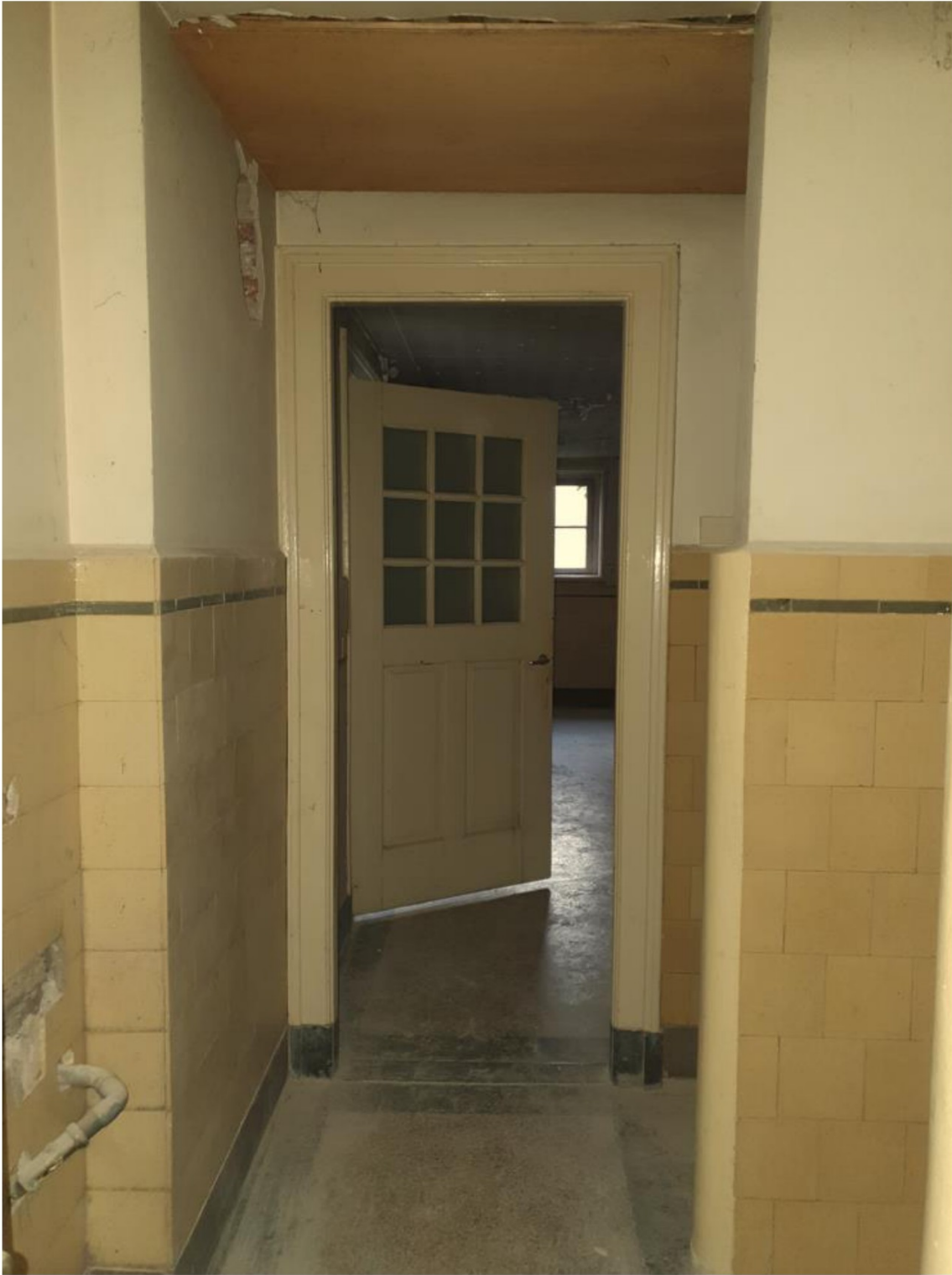
Zicht vanuit de toiletten met nog hun oorspronkelijke vloer- en wandafwerking naar gang met de achter-entree voor de leerlingen. FH MAB 2023.
