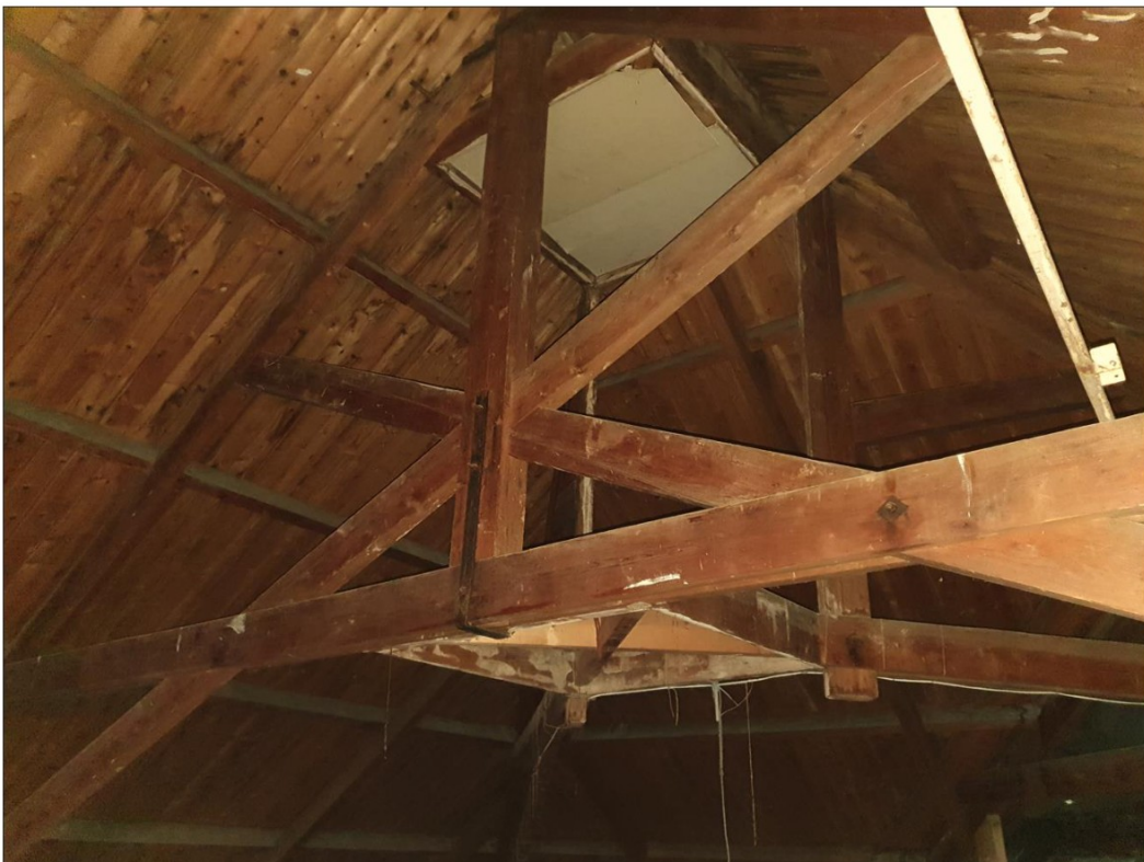
De zolder met kapconstructie met raveling voor een schoorsteen op het nokeinde. FH MAB 2023
