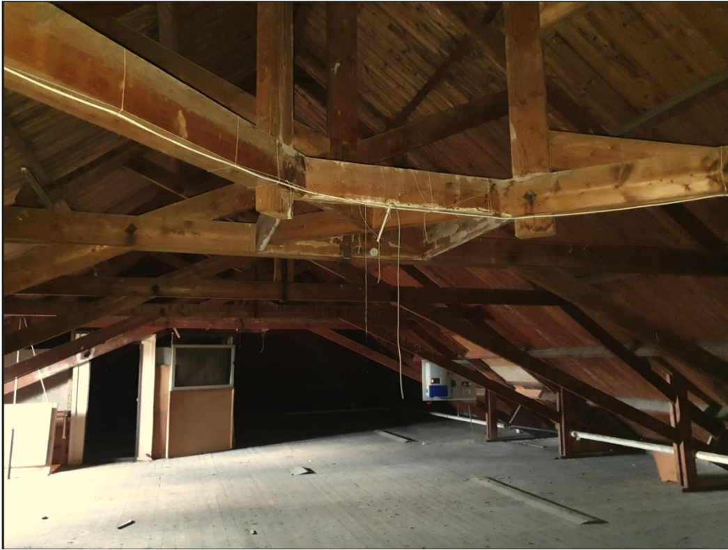
De zolder richting de Koninginnelaan gezien met op de voorgrond de in de kapconstructie geïntegreerde raveel-constructie voor een (gesloopte) schoorsteen. FH MAB 2023
