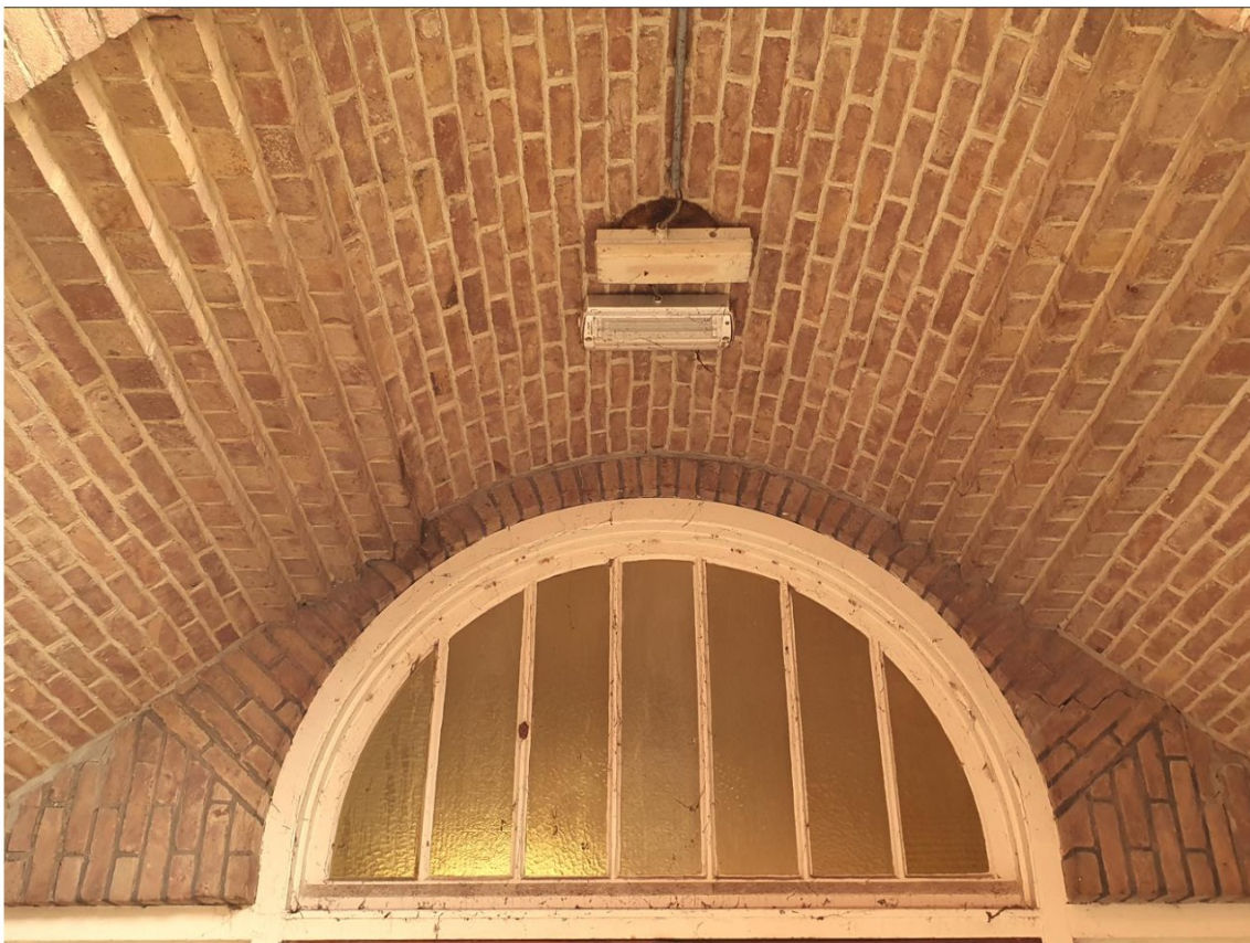
Het gewelf in de portiek en het halfronde bovenlicht. FH MAB 2023
