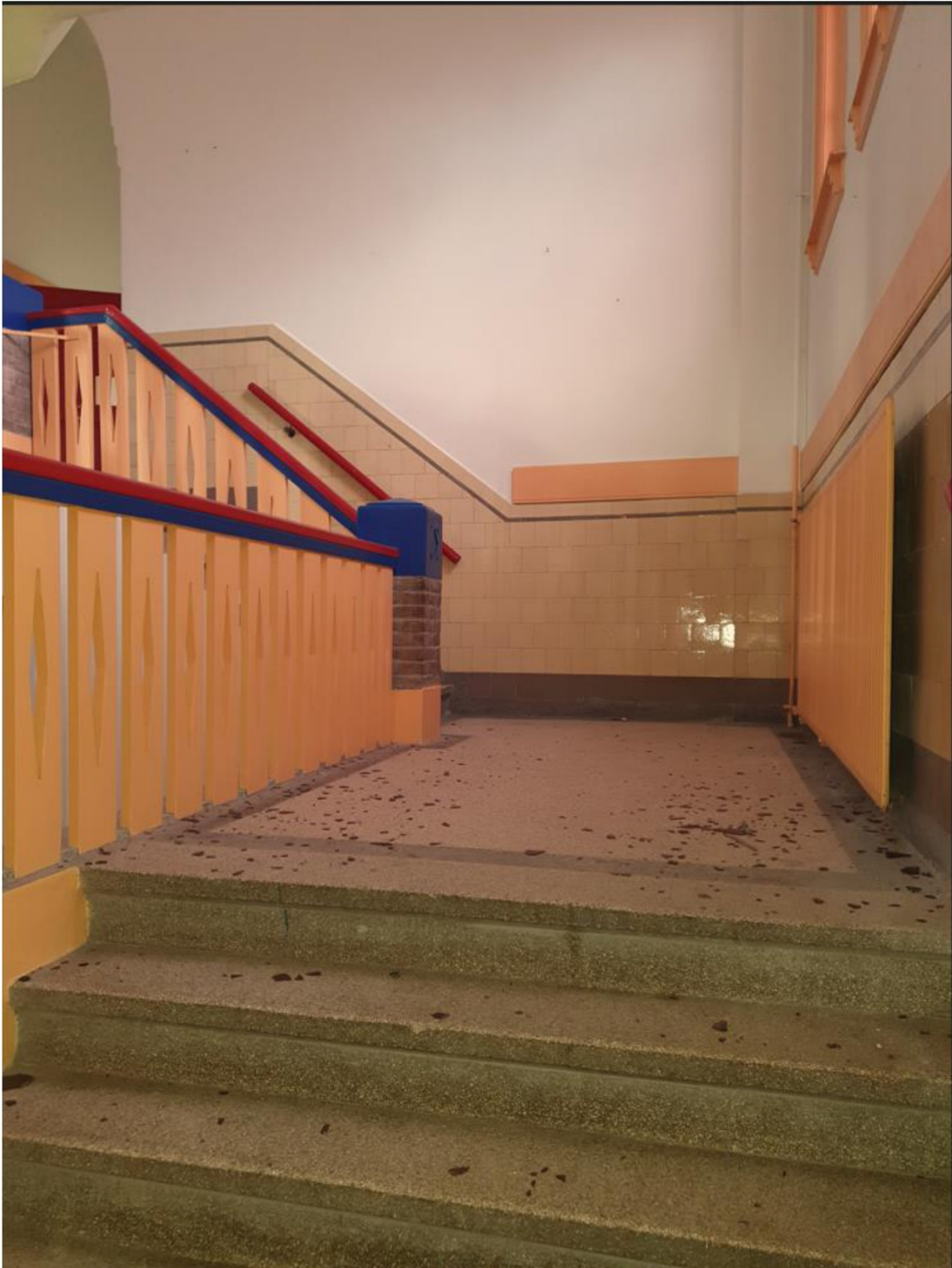
Het tussenbordes van de in beton met terrazzo afgewerkte trap boven de ingangsportiek. De tegellambriseringen en de trapbalustraden zijn nog origineel. FH MAB 2023
