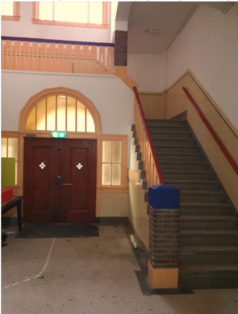
De hal met trap met de overloop over de portiek van de entree. De trap, kozijnen en de afwerking van de vloer (terrazzovloer) en wanden (tegellambrisering en stucwerk) is nog gaaf bewaard gebleven. FH MAB 2023
