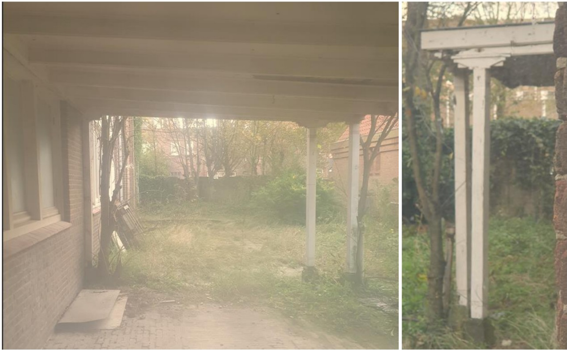
De uit de bouwtijd daterende overkapping links tegen de achtergevel. FH MAB 2023
