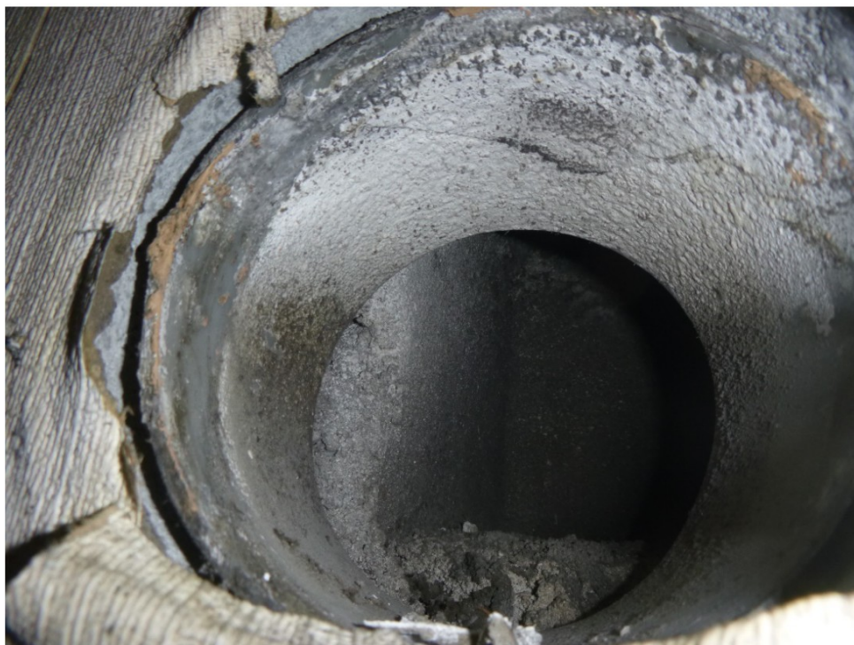
Foto 3: Zicht in een geïnspecteerd ontluuchtingskanaal in de keuken.
