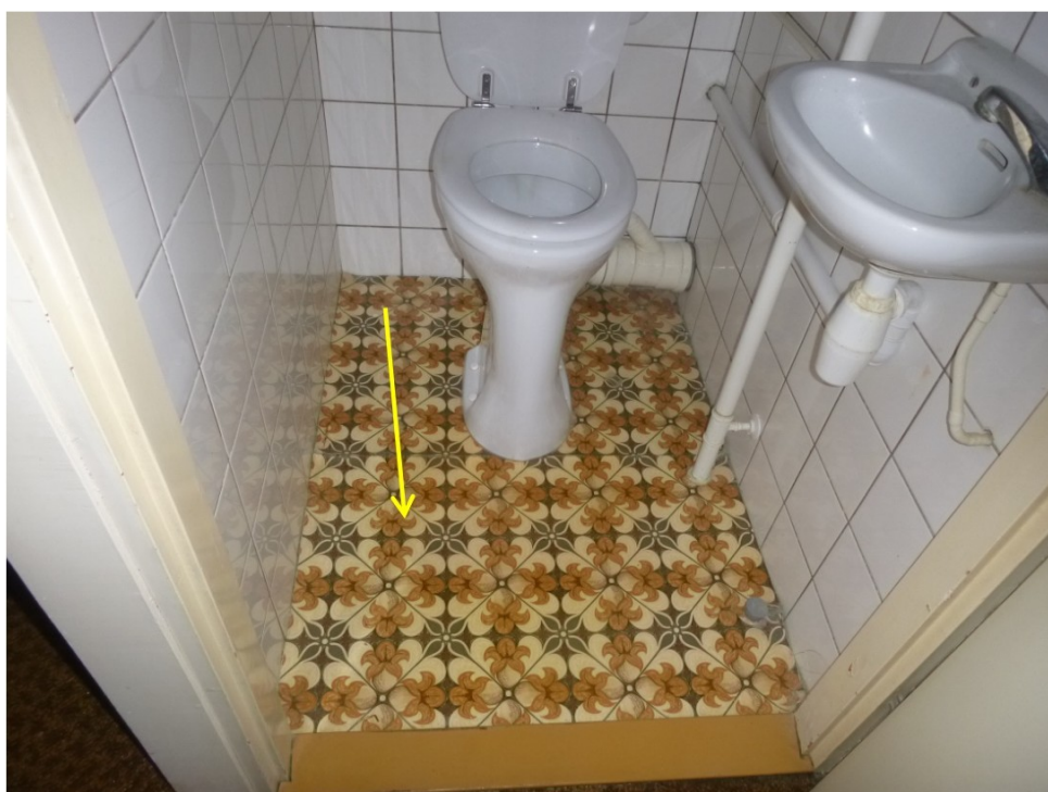
Foto 2: Zicht op bron B02 in het toilet.
