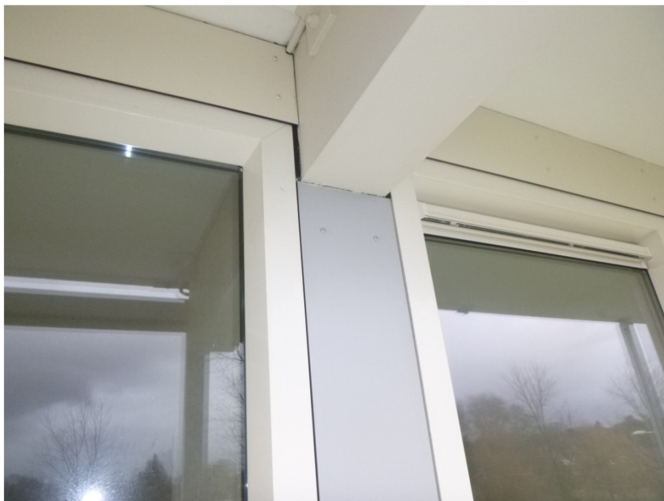
Foto 5: Zicht op de nieuwe kozijnen uit 2005 met Trespa aftimmering.
