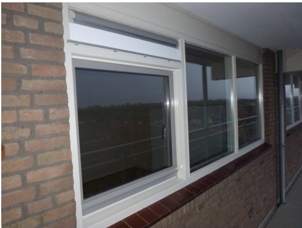
Foto 5: Zicht op het raamkozijn van de slaapkamer ter plaatse van de voorgevel.
