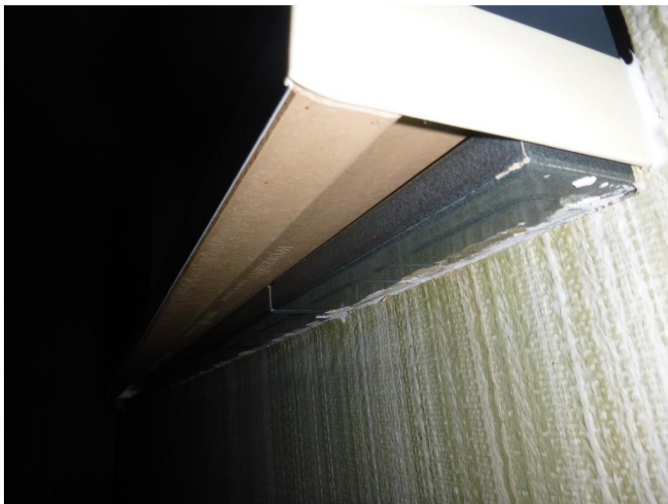
Foto 3: Zicht op de oorspronkelijke vensterbanktegels onder een nieuwe houten vensterbank.
