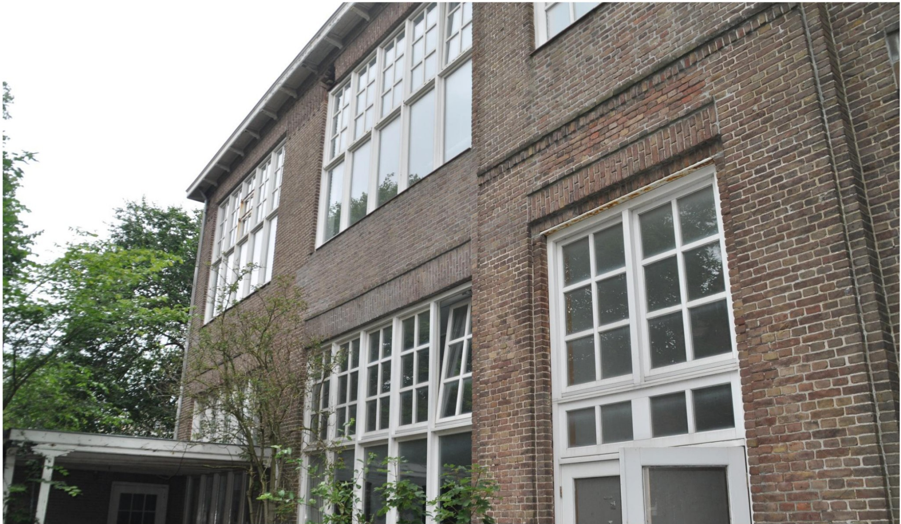
Achtergevel – tuinzijde – zuidwest
