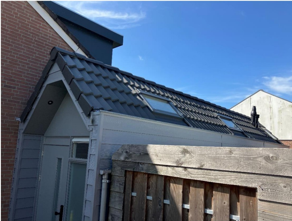
Twee dakramen aan de noordzijde
