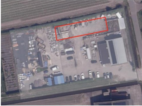
Figuur: project in bestaande situatie op stelconplaten
